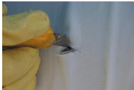
图 10.5.5 扎头部分外面防紫外线膜划开示意图
