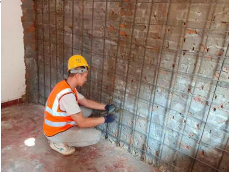
图 5.1.1-5 钢筋混凝土板墙加固示意 图 5.1.1-6 新增钢筋混凝土圈梁及构造柱加固示意
