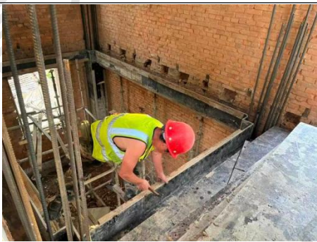
图 5.1.1-5 钢筋混凝土板墙加固示意 图 5.1.1-6 新增钢筋混凝土圈梁及构造柱加固示意
